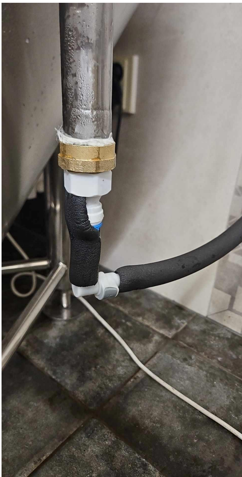
Detail hadic s napojenou izolací.
