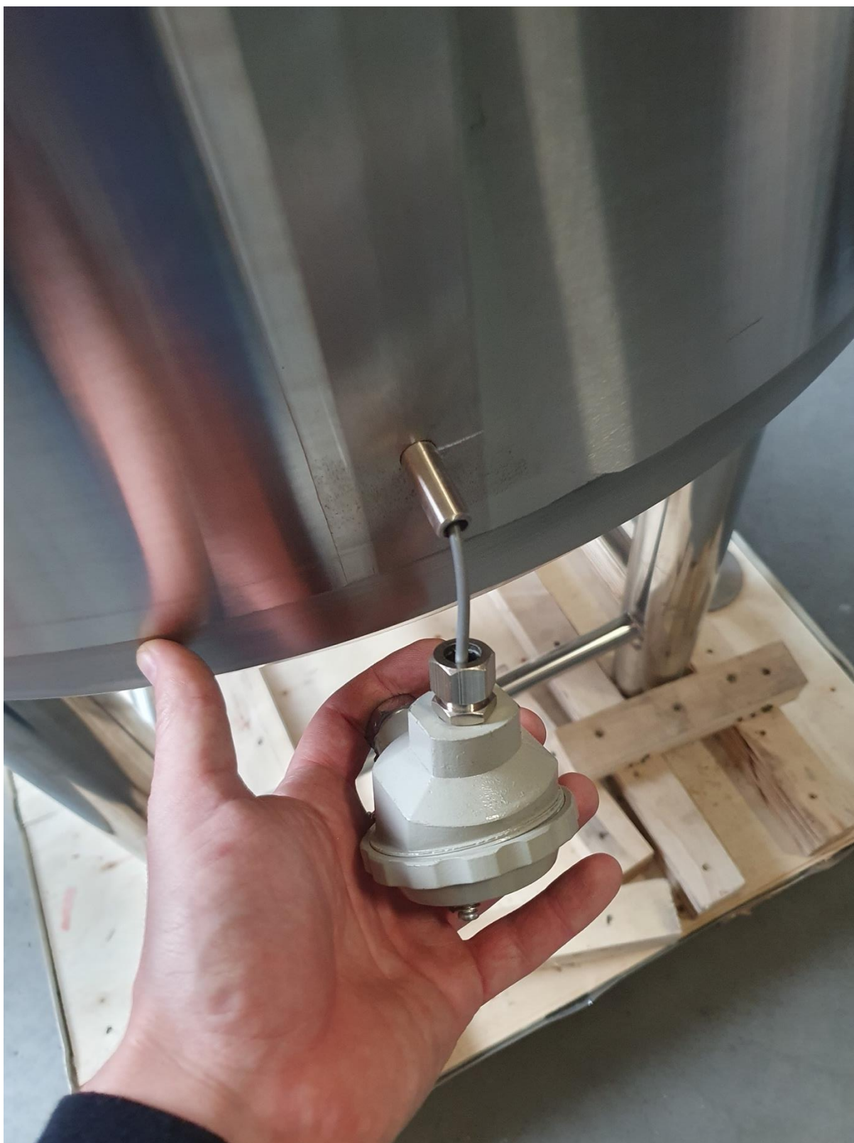
Teplotní čidlo vsuňte dovnitř teplotní jímky.
