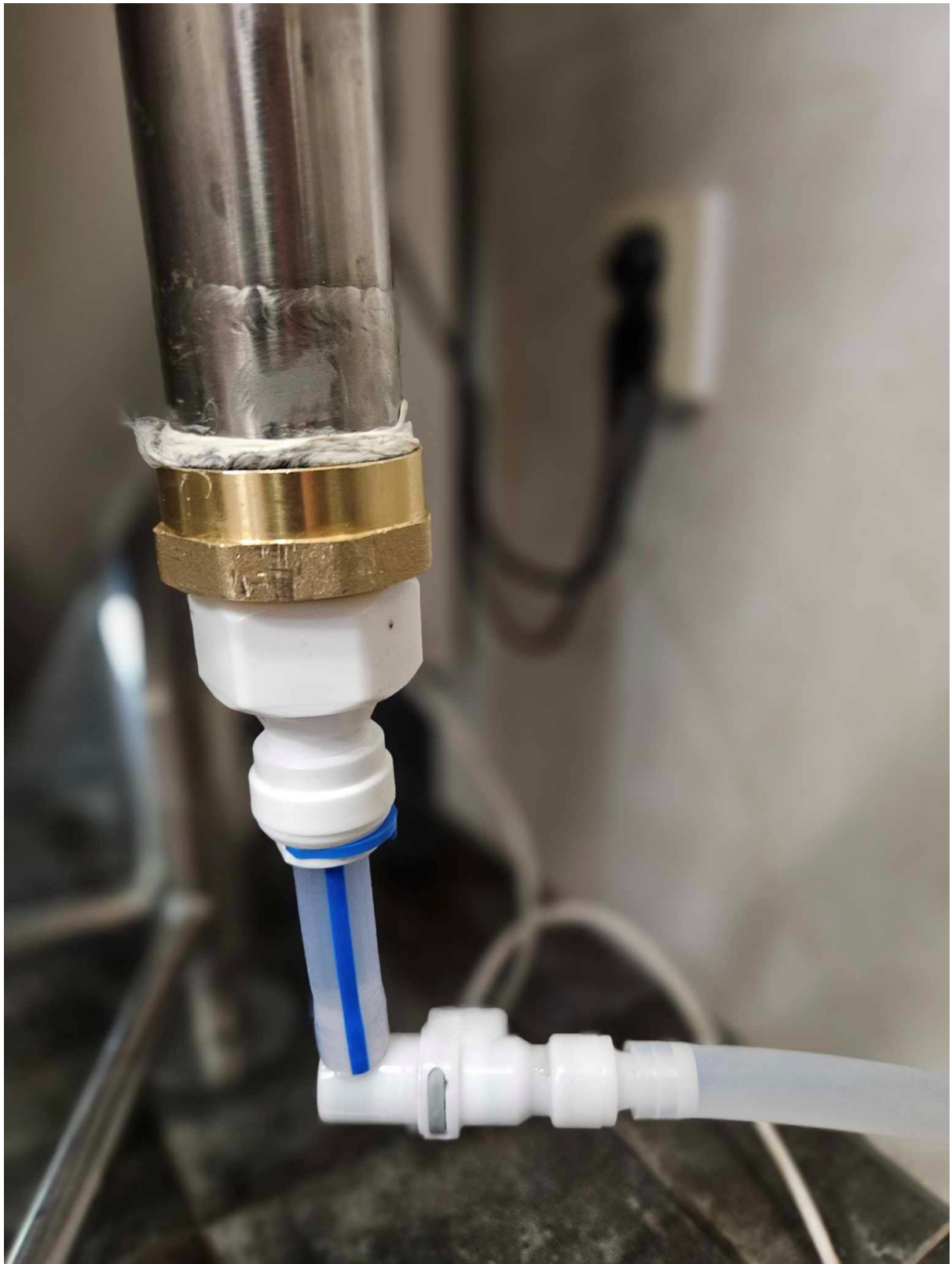
Detail zapojení chlazení pomocí 9,5 mm trubky a rychlospojky od dodavatelů John Guest a Brewtools.
